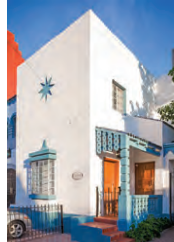
Casa en avenida de la Paz
